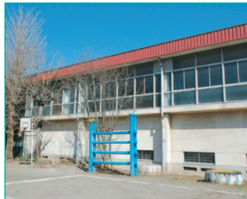
地震補強工事を予定している阿蘇小 学校の体育館
