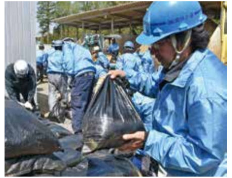
▲36人で半日かけて土のうを作りました
