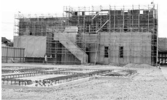
▲今年度の竣工を目指して工事が進む東消防署庁舎
