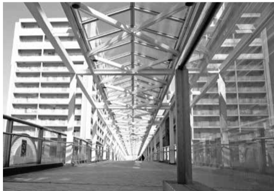
▲八千代緑が丘駅北口の歩道橋。引き続き南口を補修
