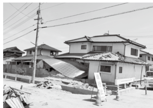
▲倉敷市真備町で豪雨のため屋根瓦などに被害を受けた住宅
