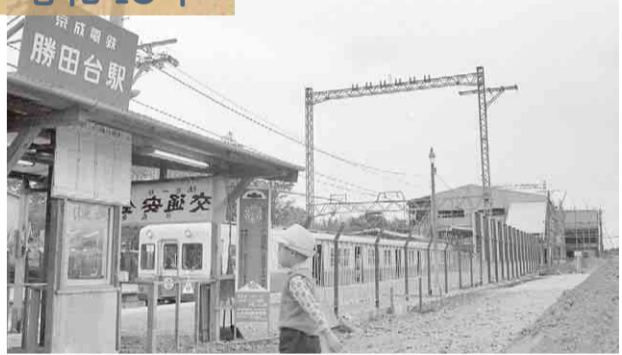
▲昭和43年開業。跨線橋が工事中だったため、仮設の改札が設置されていました
