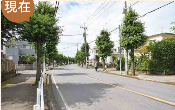
▲外周道路に沿って住宅や店舗などが建ち並びます
