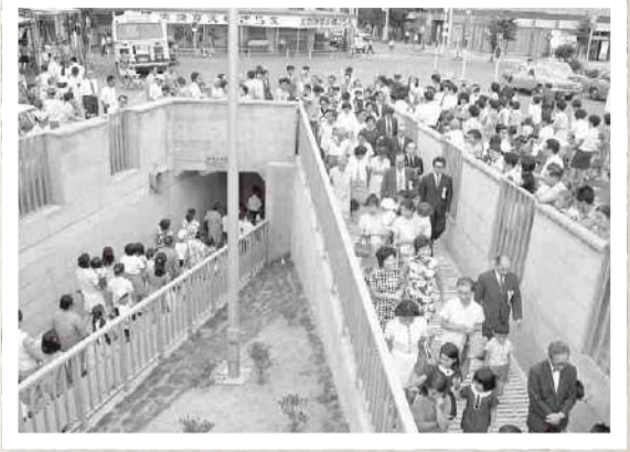
▲昭和46年8月に開通した東口と西口をつなぐ地下道開通当日の様子(写真は西口側)
