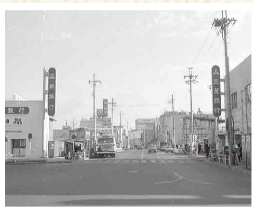
▲昭和47年ころ。駅前には現在も営業している銀行が建設されます
