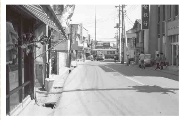
▲昭和44年ごろの大和田駅北口の様子。現在も営業する銀行の支店も見えます
