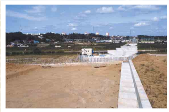
▲昭和57年ごろの建設中の新川大橋の様子。新川の向こうに村上団地などが見えます
