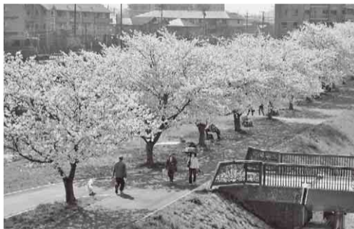
▲きれいな桜並木の復活に向けて苗木の植栽工事を行います
