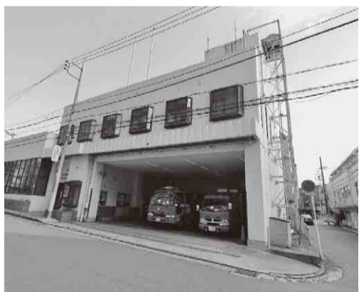
▲耐震補強などの工事を行い、防災機能を向上させます
