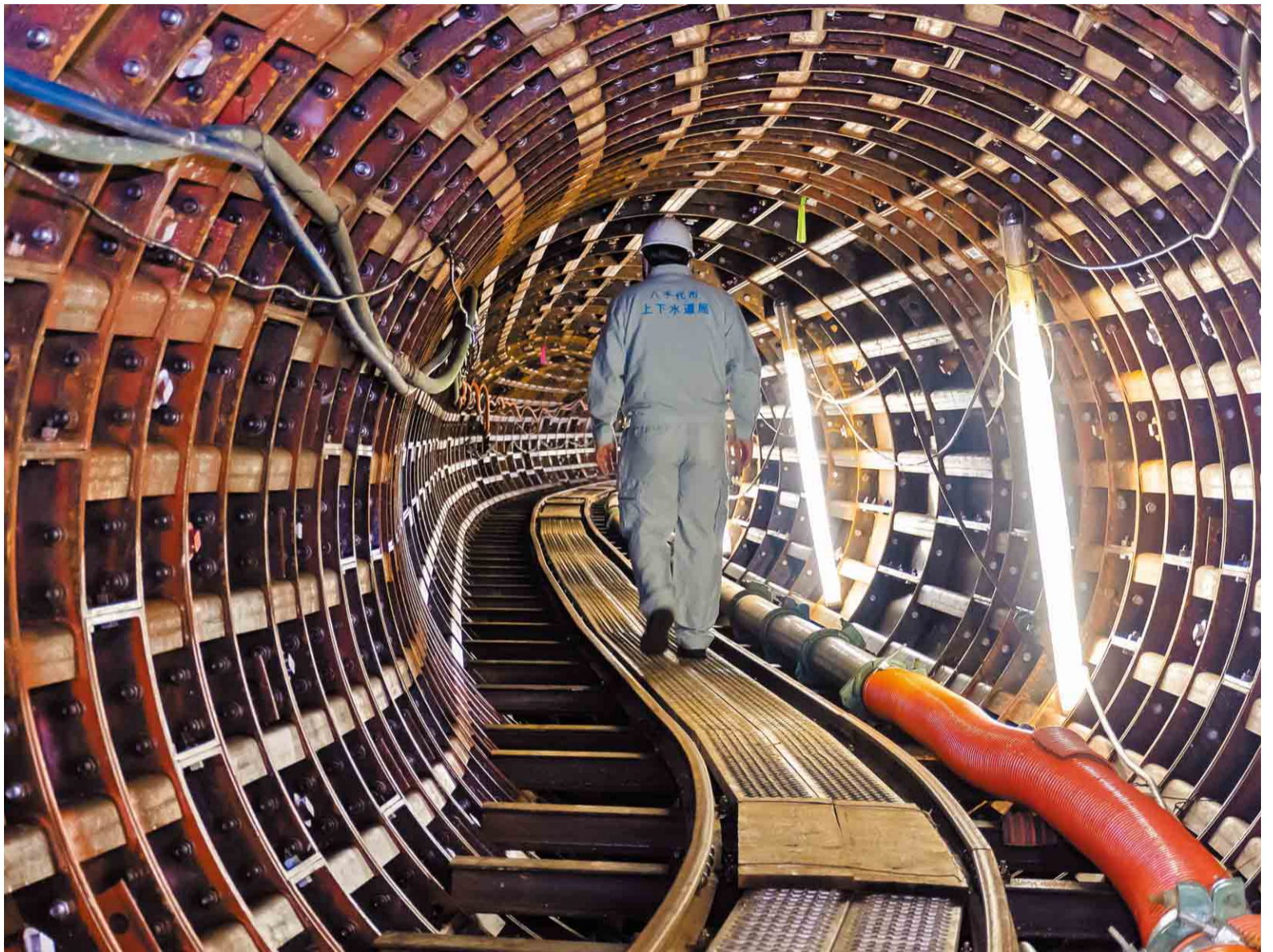
▲流下型貯留管(内径2メートル)の布設工事。写真中央下にあるレールの上は、物資を運ぶトロッキが走ります
