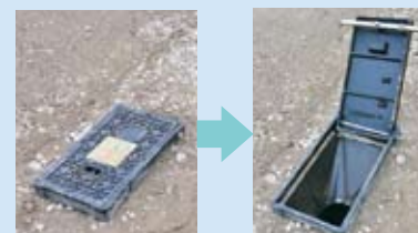
▲マンホールは、災害時にはトイレに(テントなどで囲って)使用します
