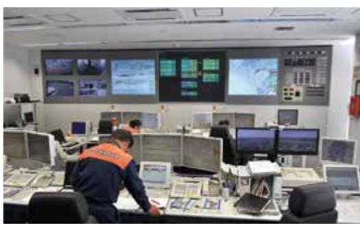
八千代市消防本部は、高機能指令管制システムを導入しています。通報を受けると同時にシステムが稼働して、通報者の住所地点を画面に表示します。通報内容を聞き、災害地点の住所を入力すると、画面に災害地点の地図を表示。火災・救急・救助など災害の種類を入力すると、状況に応じた最適の部隊を編成し、自動音声装置と指令書で地区を管轄する消防署に指令を出します。
