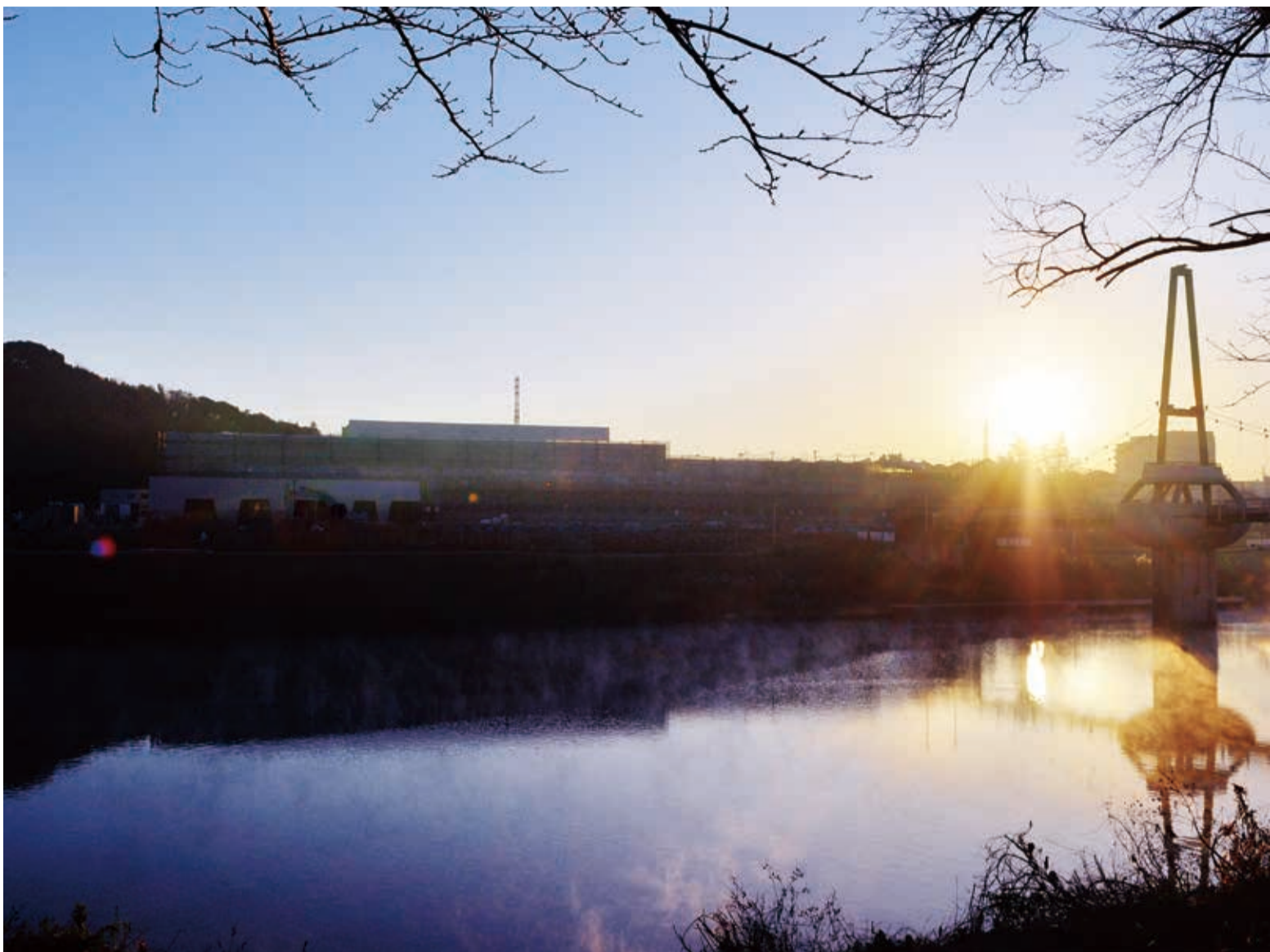
▲朝日に照らされた建設中の中央図書館・市民ギャラリー
