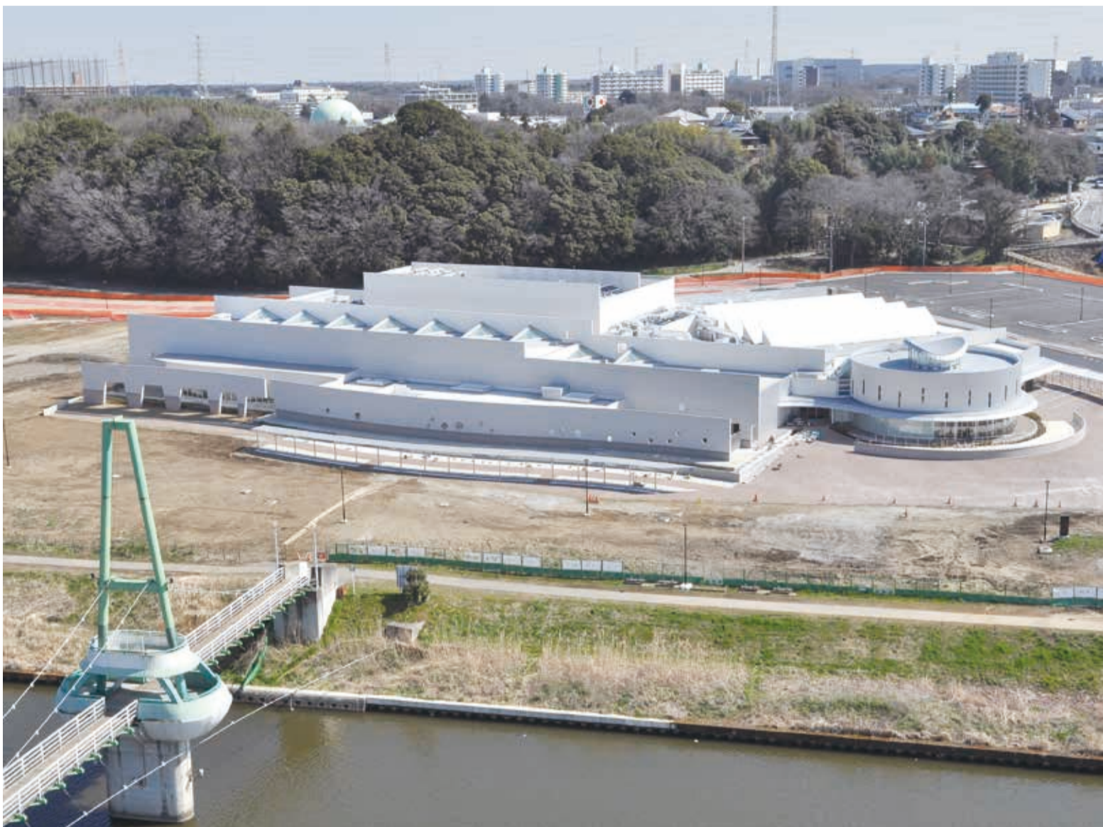
▲建設中の中央図書館・市民ギャラリー。建物のデザインは、新川の水面に立つ波紋やさざなみから広がる空間をイメージしています(3月13日撮影)
