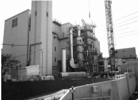
▲焼却炉施設基幹的設備等改良工事の様子
