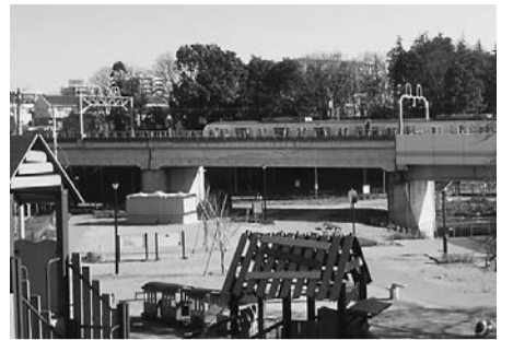
▲東葉高速鉄道は高架橋柱の耐震工事を行います
