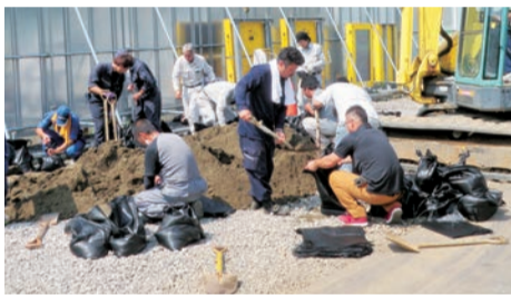
▲土嚢を作る管工事協同組合の皆さん
