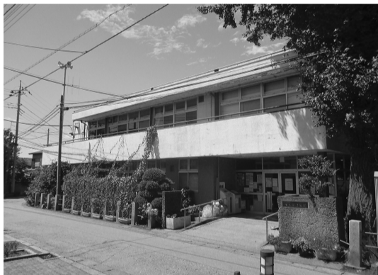
▲大和田公民館では耐震診断を実施
