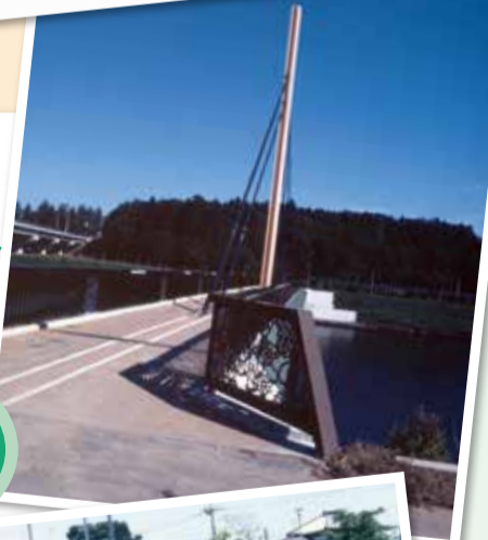
親子橋(新川大橋、なかよし橋) 開通(昭和59年)
