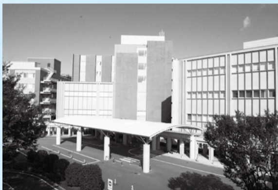
▲第2病棟が完成した八千代医療センター
