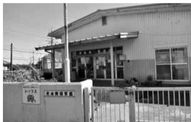
▲耐震改修工事を行う米本南保育園
