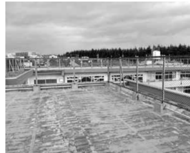
▲防水改修予定の八千代台西小学校屋上
