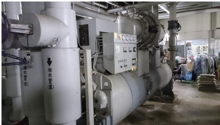
冷房用ターボ冷凍機
