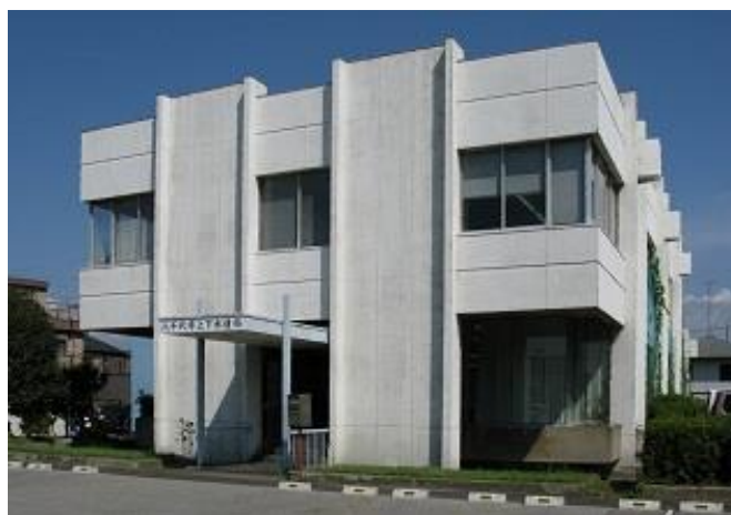
図 2.10 上下水道局庁舎
