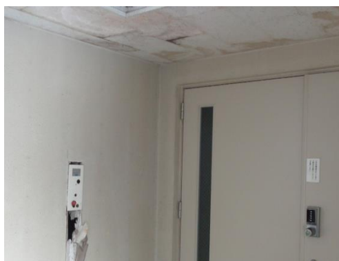
図 2 老朽化の現状(左:雨漏り跡，右:老朽化した配管)
