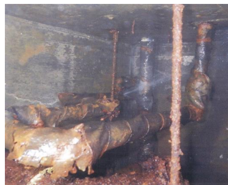
図 2 老朽化の現状(左:雨漏り跡，右:老朽化した配管)
