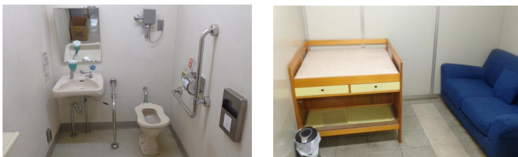
図5 車いす用トイレとオムツ換えコーナー兼授乳室
