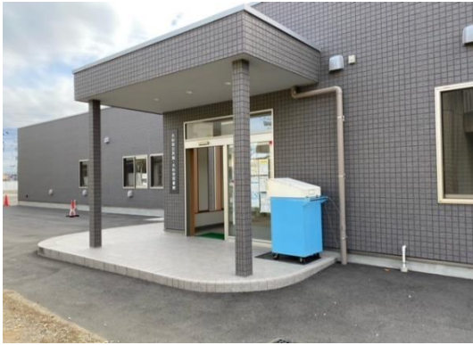
＜大和田図書館 本館 外観＞
