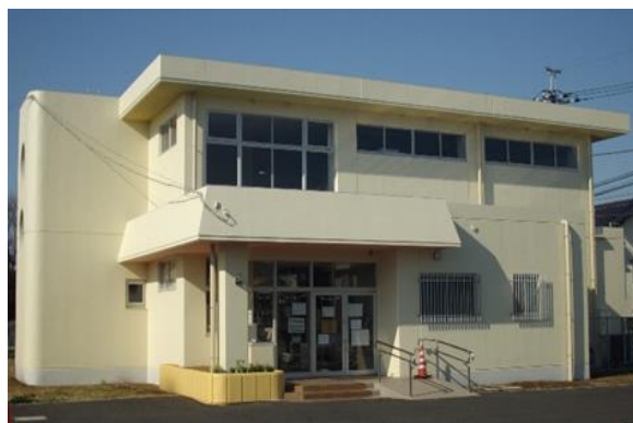
＜大和田図書館 別館＞
